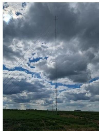
Un mât de mesure a été installé sur la commune de MAZINGHIEN en Avril 2024, à l'intérieur de la ZIP, à un emplacement, accessible et proche d'un chemin, et représentatif des vents de la ZIP. L'ancrage au sol du mât de mesure est assuré par 3 lignes d'haubannage, d'où sa représentation en étoile rouge à 3 branches sur la carte.
