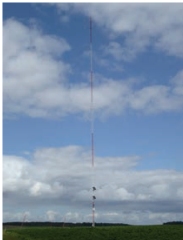
Exemple de mât de mesure du vent
